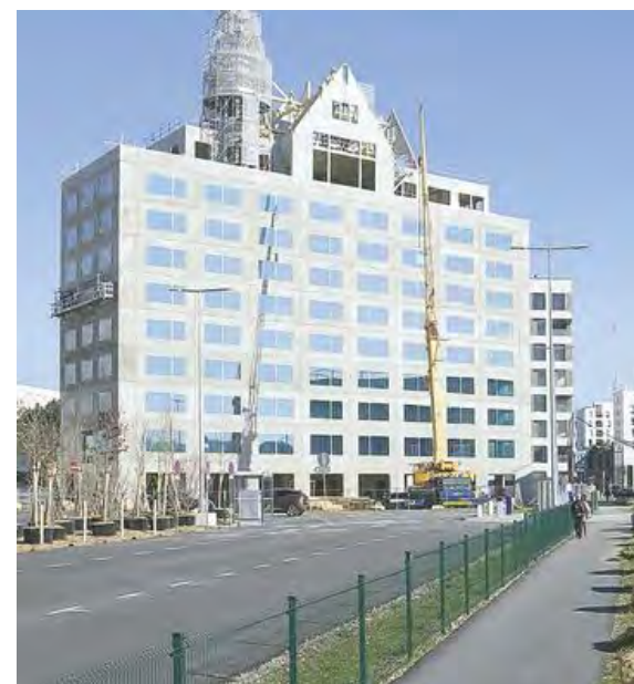
Hôtel de Philippe Starck en chantier
