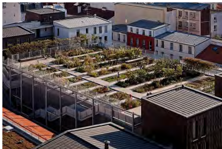
Atelier TOA, rue des haies, paris
