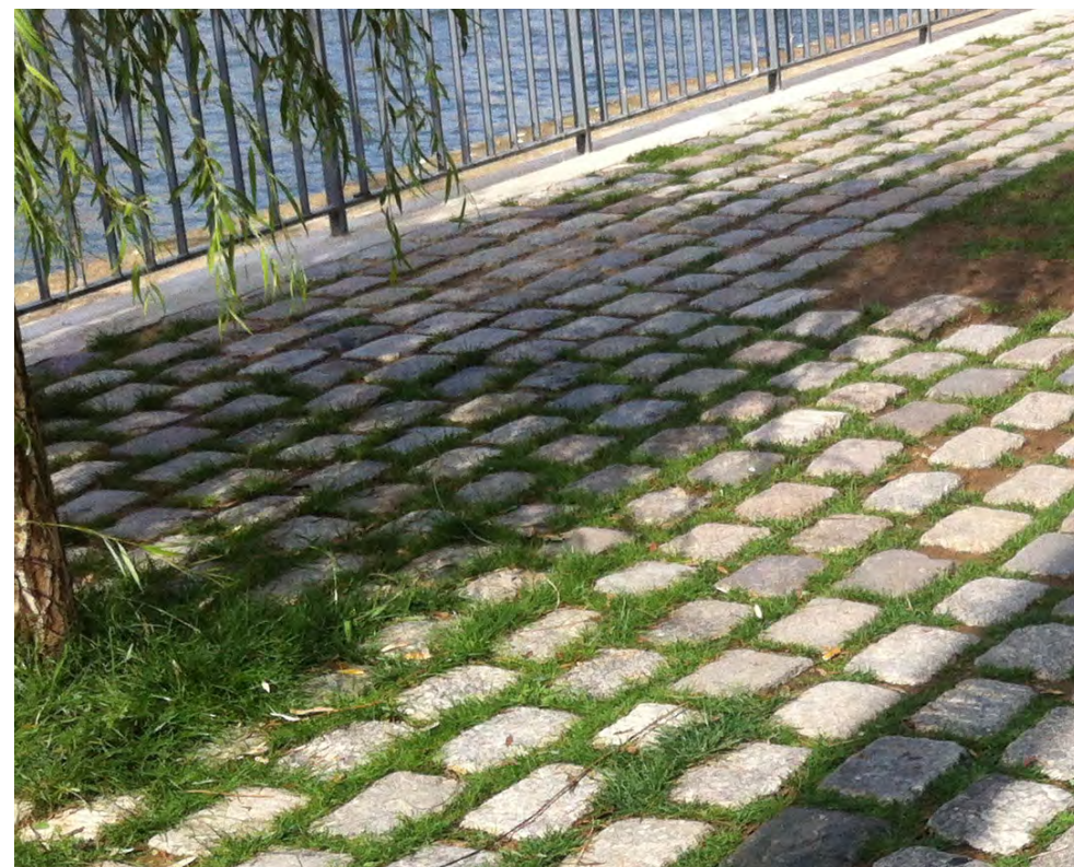
référence : allée piétonne non imperméable et allée piétonne de largeur minimale, étroite et perméable
