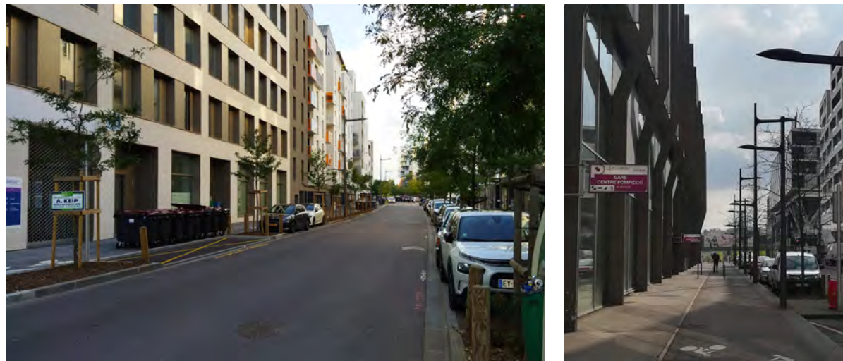
voirie en enrobé, bordures et caniveaux en béton granité, stationnement en enrobé, trottoir en béton désactivé et piste cyclable en béton désactivé plus sombre (photos de la rue des Messageries)
